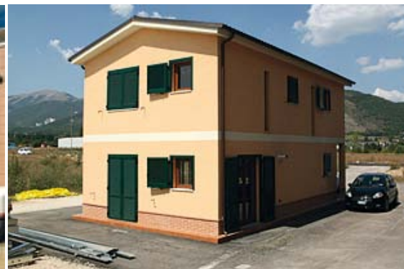
Tipo Edificio: Costruzione edifici Particolarità: 2 piani con tetto a falde manto sintetico.
