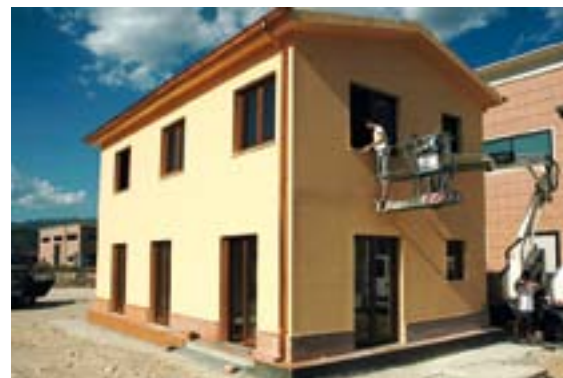
Località: Sassa Scalo (AQ) Cliente: Steel Building Anno costruzione: 2009
