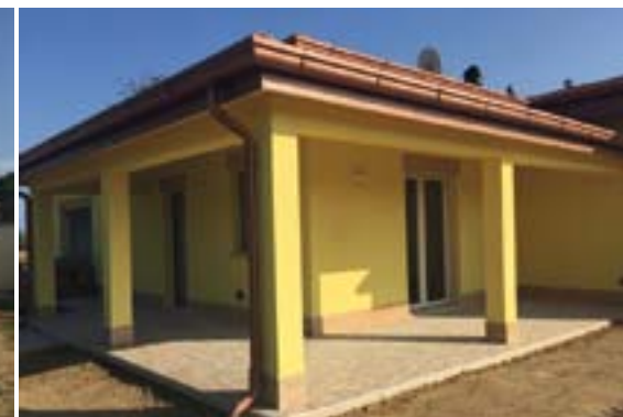
Tipo Edificio: Villetta Unifamiliare Particolarità: 1 piano con tetto a 5 spioventi.
