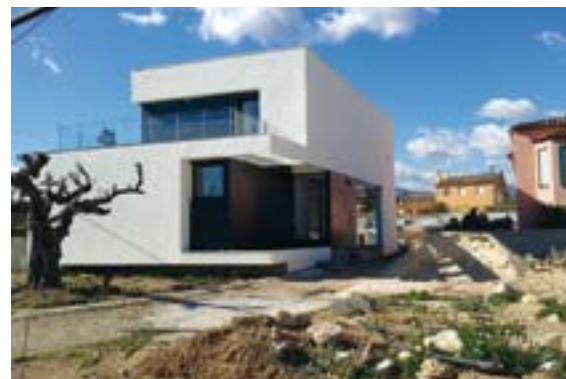
Località: Bologna Cliente: Maurizi Anno costruzione: 2013
