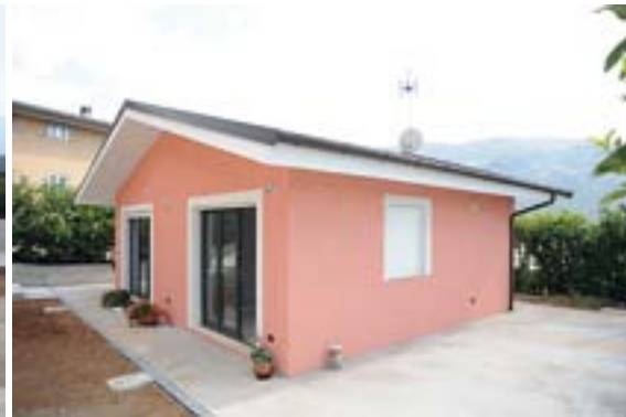
Tipo Edificio: Villetta Unifamiliare Particolarità: Tetto a falde coppetto.
