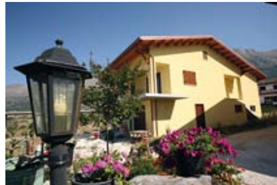
Località: Assergi (AQ) Cliente: Mucciarelli Anno costruzione: 2011
