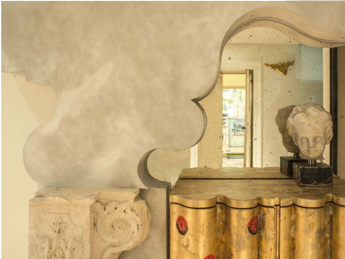
Sagomatura in cartongesso con finitura invecchiata
